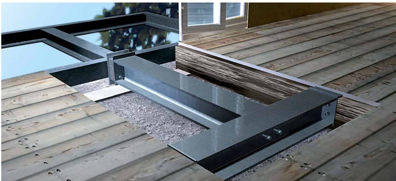
Vytvoření nové ocelové konstrukce balkónu z prostředí stávajícího dřevěného trámového stropu.
